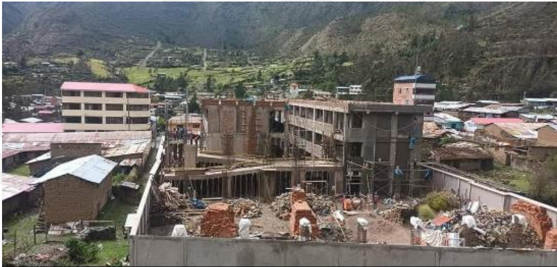
Figura 3: Imagen de la I.E. N° 50166 en construcción.
