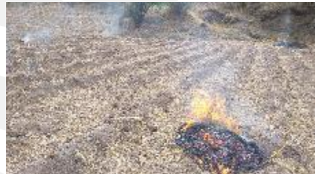
Foto n.º 1: limpieza de terreno
